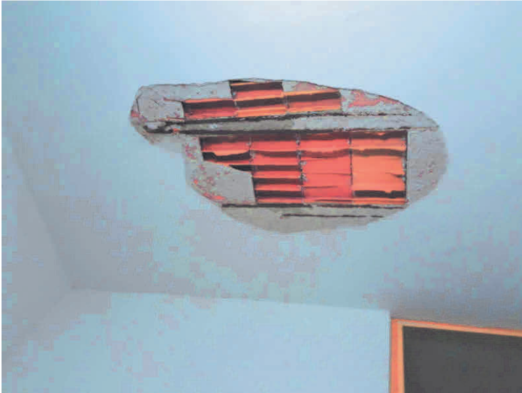
Crollo intonaco da solaio sottotetto scala Canonica
