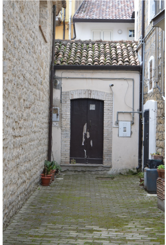
FOTO 1 Ingresso alla sacrestia
