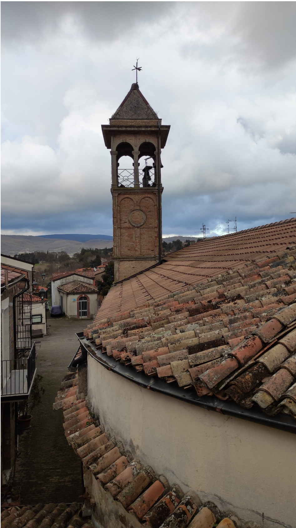
FOTO 8 Vista della copertura laterale e del campanile
