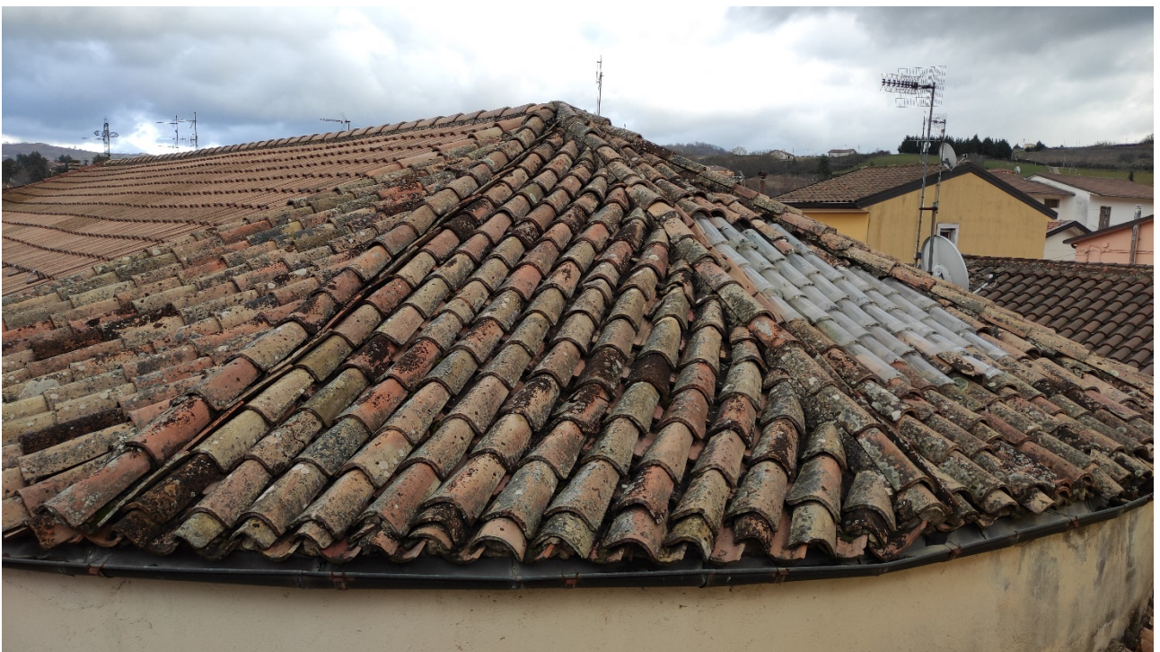
FOTO 7 Vista della copertura absidale
