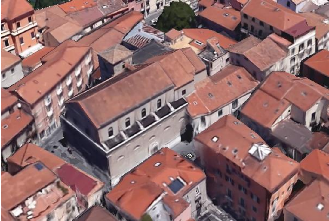
Figura 7 – Vista aerea del contesto urbano di interesse.
